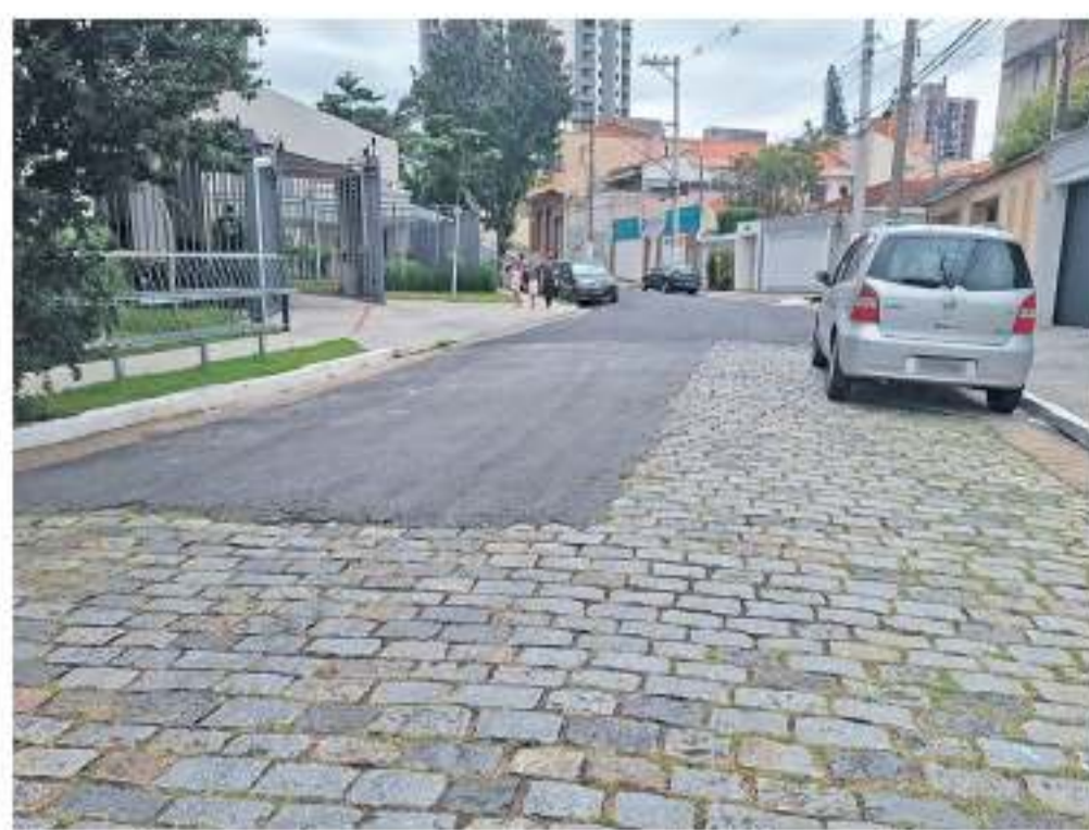
Moradores não aceitaram o asfaltamento
