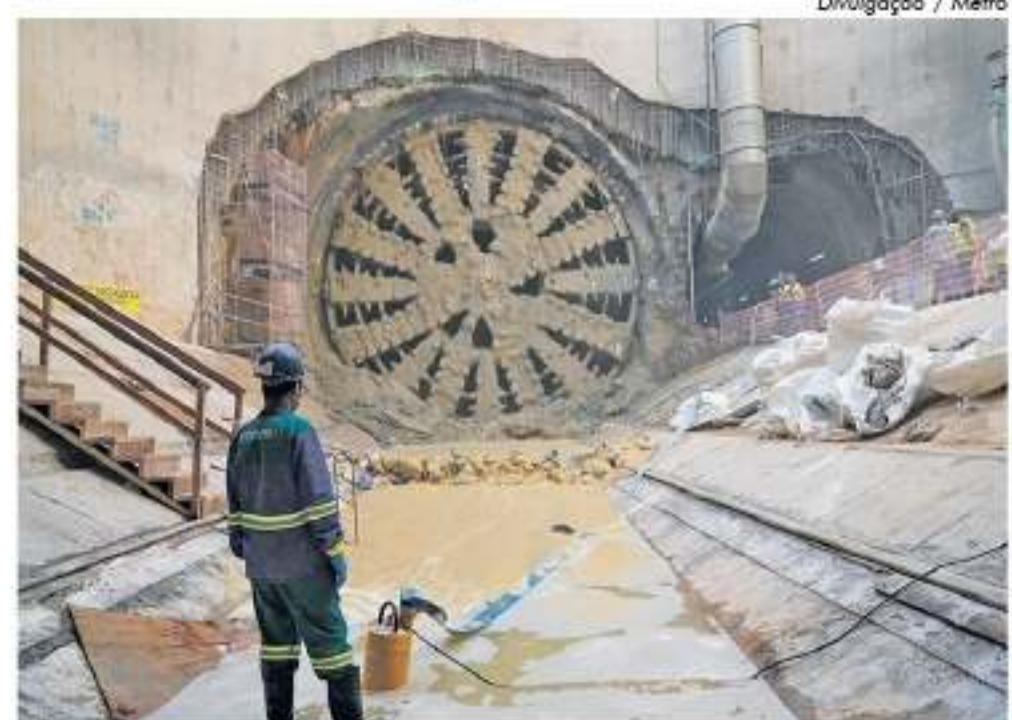
Tuneladora que abre os novos túneis da Linha 2 é a maior em operação na América Latina
