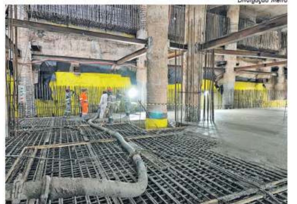
Foram lançados cerca de 1.540 m³ de concreto
