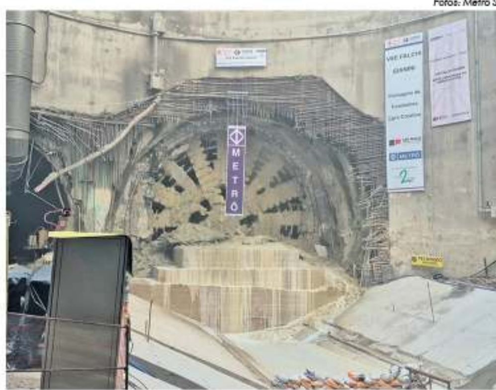
Tuneladora atingiu o poço Falchi Gianini no dia 30
