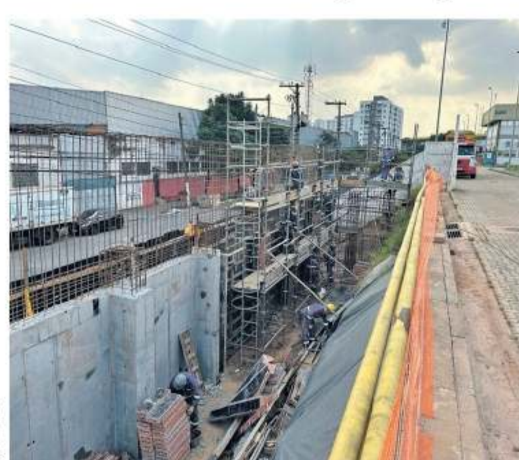
Também está em construção um muro contra enchentes
