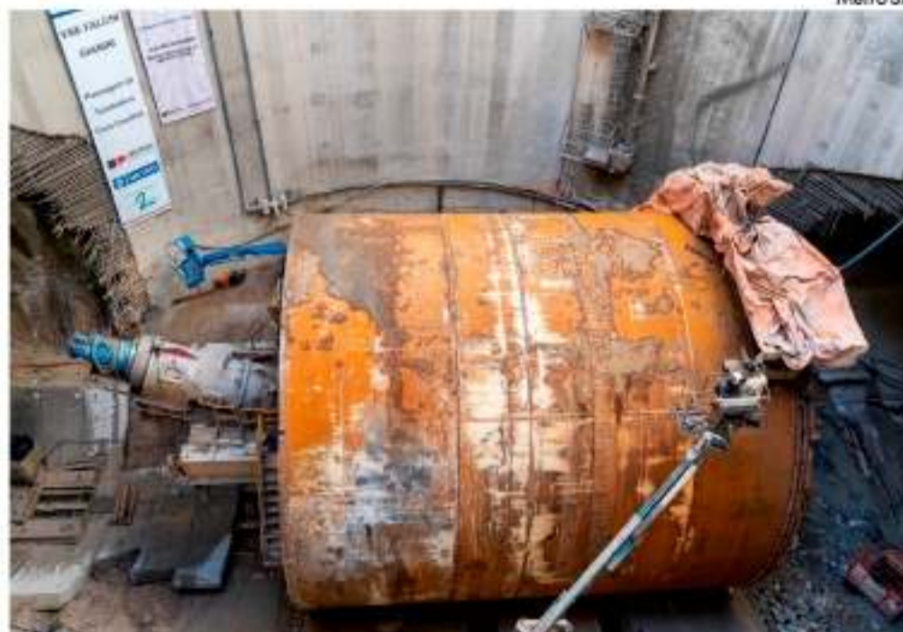
O Metrô iniciou desmontagem da tuneladora e peças serão levadas para canteiro de obras na Penha
