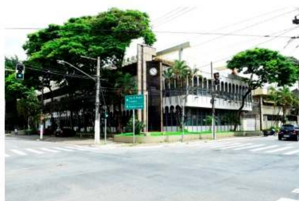
Imóvel na rua da Mooca foi leilado pela Prodesp
