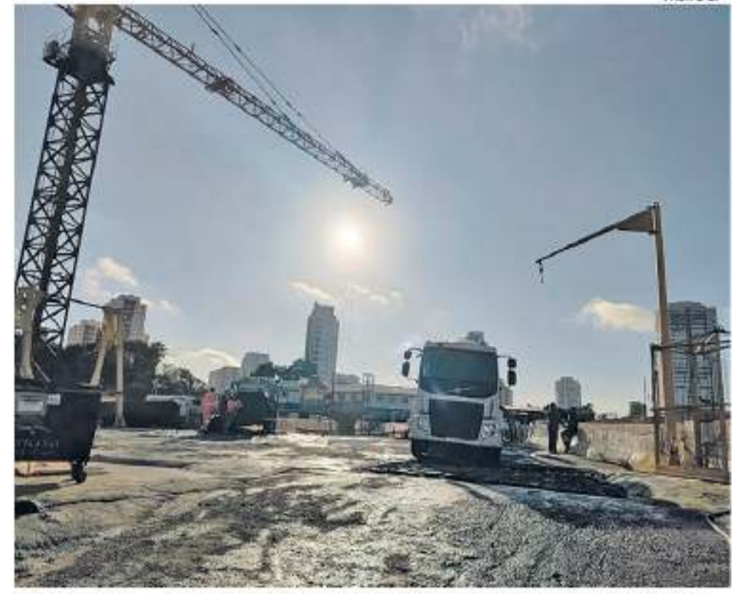
Etapa de concretagem também avançou na futura estação Santa Isabel, no Carrão
