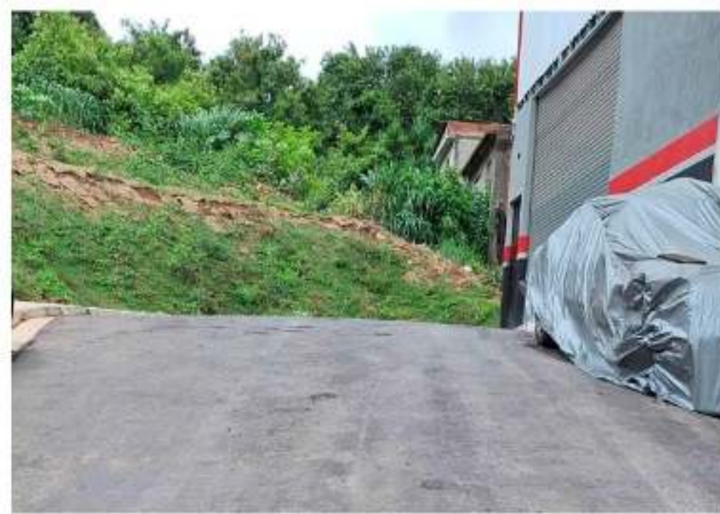
Rua dos Crépis aguarda complemento de obra
