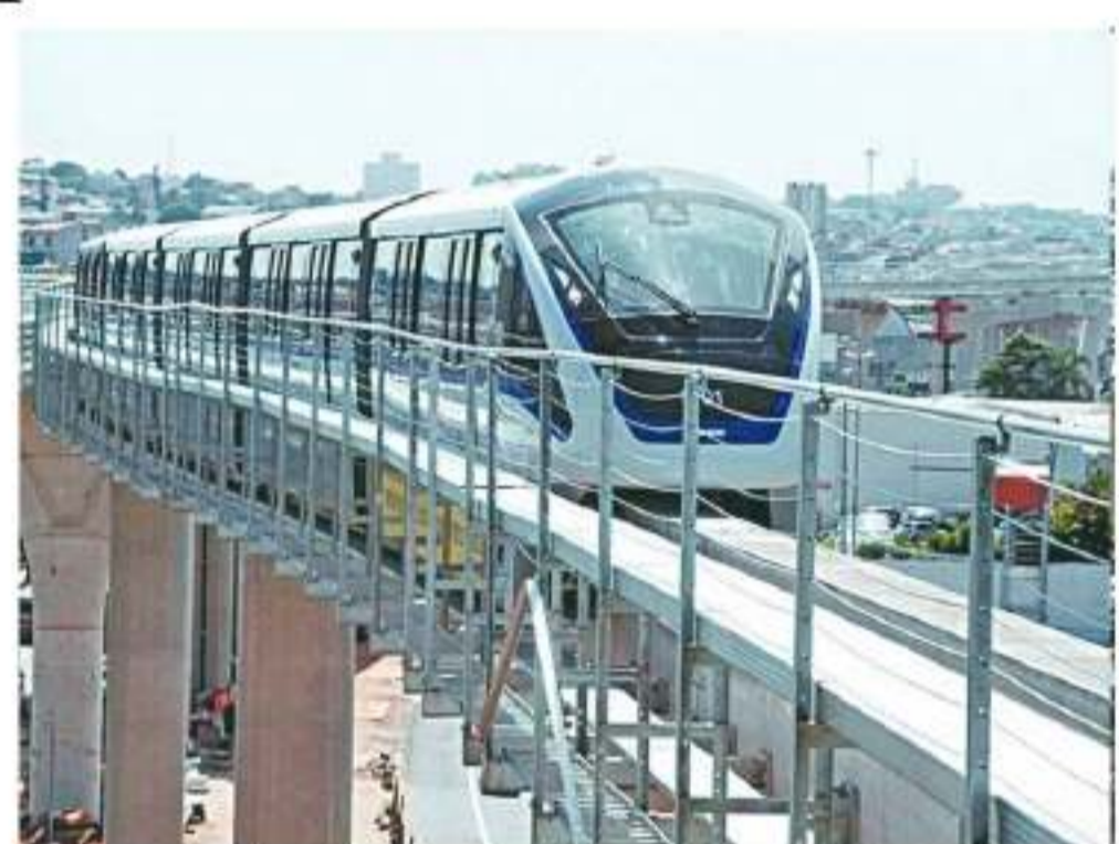
Composições operam de maneira automatizada
