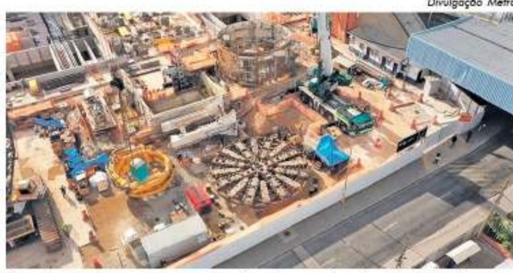
Equipes desceram a roda de corte da tuneladora
