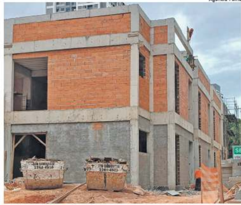
Imóvel em construção na avenida Alberto Ramos
