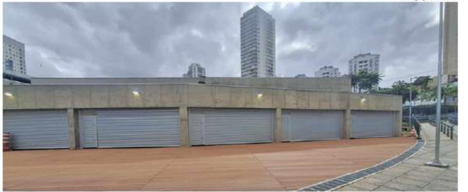
Novo espaço para locação fica na área externa do acesso recém-construído
