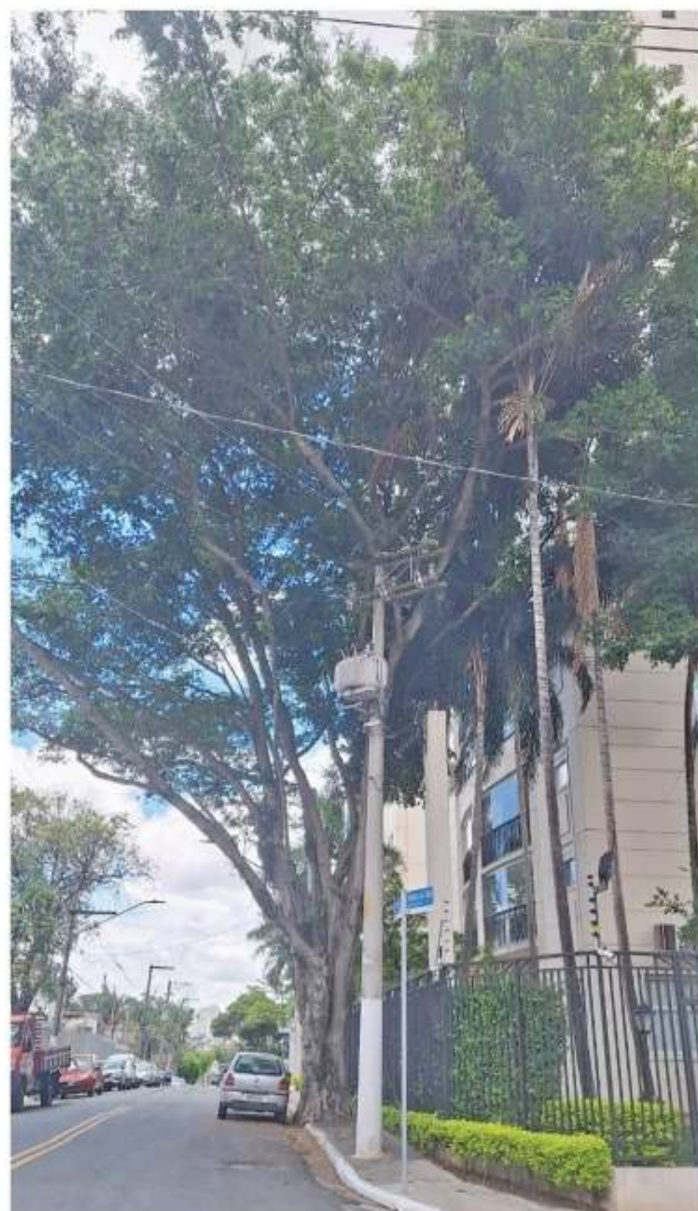
Galhos da árvore na rua Pedro de Godoi estão colados na fiação da rede elétrica
