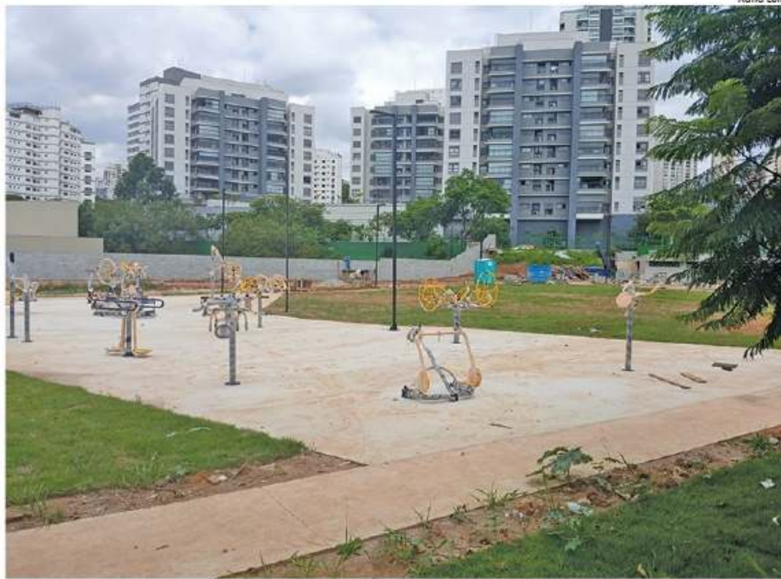
Obras de construção começaram em junho de 2024 e a primeira promessa de inauguração era ainda naquele ano
