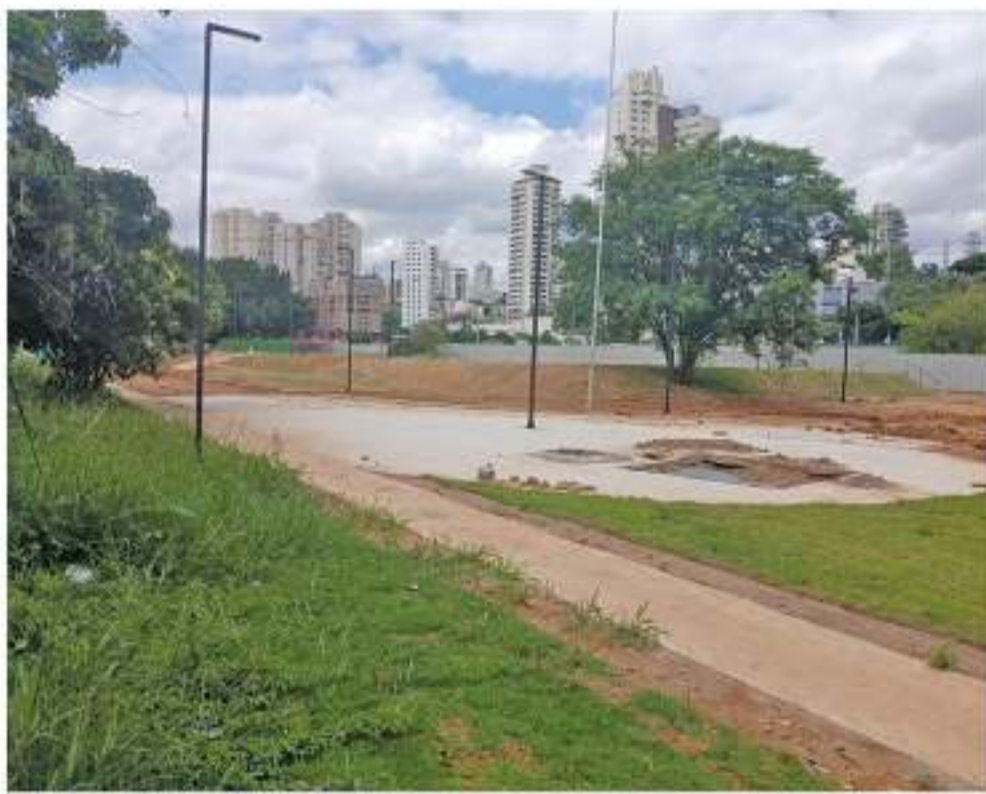
Segundo a Prefeitura, as obras de implantação ultrapassaram 65%, mas em vários trechos se avista apenas o percurso principal
