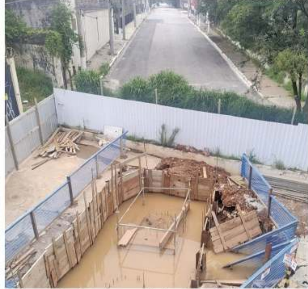
Futura pilastra do ramal de monotrilho em construção na Anhaia Mello com a Henry Ford
